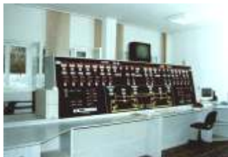
Fig. 4- Tabloul general pentru o stație de electrocompresoare
